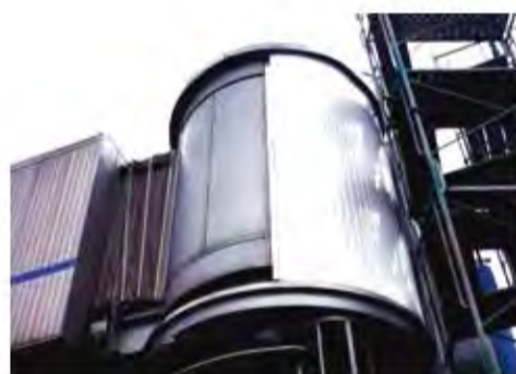
W1,500×H3,500 アルミ製(シルバー) 電動式、片引き仕様、流し込み型、全体R=2,000
